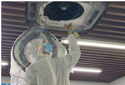
清洗消毒空调风口
