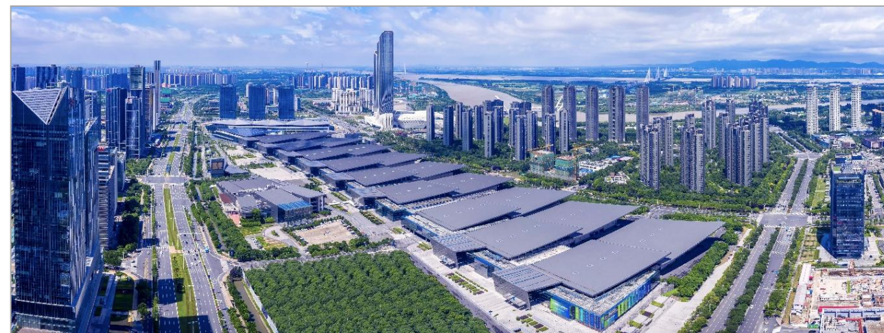
南京市国际博览中心改造为方舱医院
