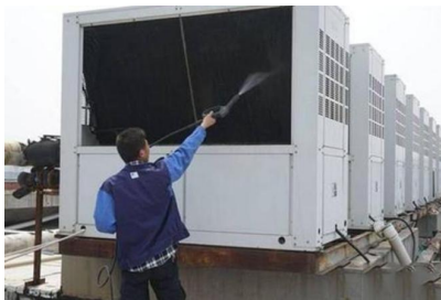
清洗消毒空调风口
